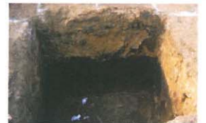
縦横1.2m、深さ1.2mの穴を掘削
